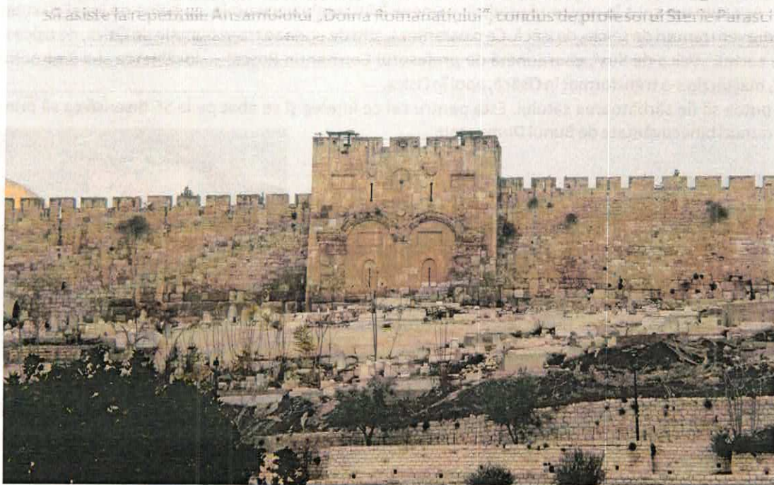
Vedere generală a Cetății Ierusalimului
